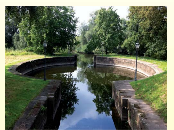
Lauenburg, Palmschleuse, dort stand die erste Kammer- und Zäpfeltaggen in Europa. Diese Schleuse wurde 1723 gebaut und 1962 restauriert.
